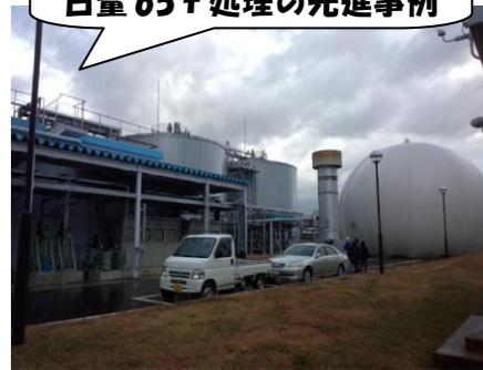
13 年 7 月、長岡市は、焼却施設と下水処理場に隣接して、年間 410 万キロワットの発電施設を稼働させました。おむつなどを除去した生ゴミを大量の水で希釈してメタン発酵を行うという、大変シンプルな仕組みです。希釈・排水処理に、下水施設が有効に働いています。
